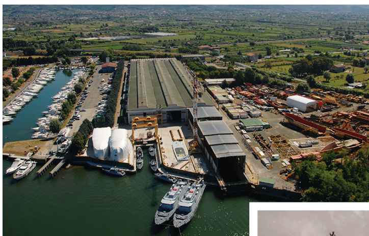
Cantiere di Sarzana (SP)
